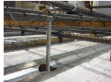
b) Steel bonding rod
