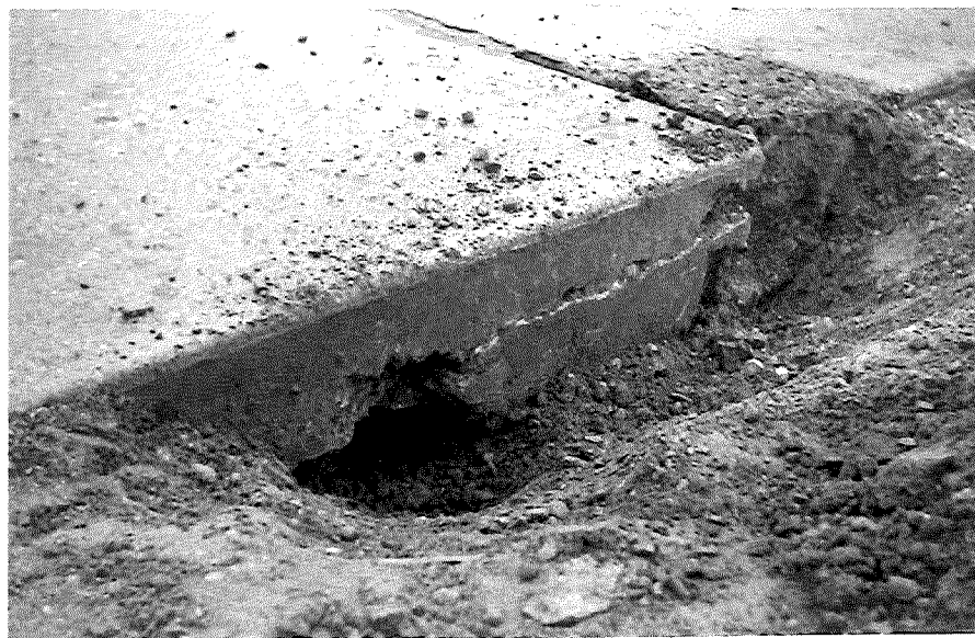
Sta 262+25, Proj 72-7, C5; constr 1947 (Nov '54)
