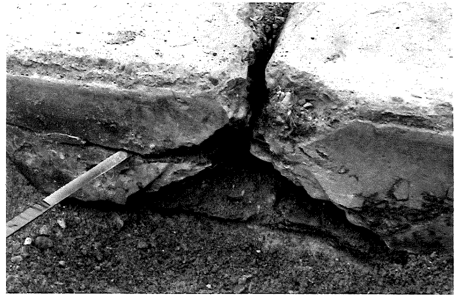
Sta 207+09, Proj 47-26, C6; constr 1948 (Nov '56)
