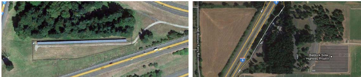
a. I-5/205 Solar Array
