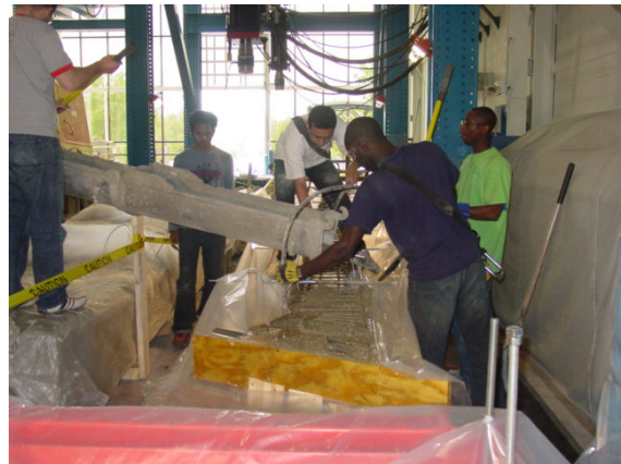
(d) Casting of box-beam
