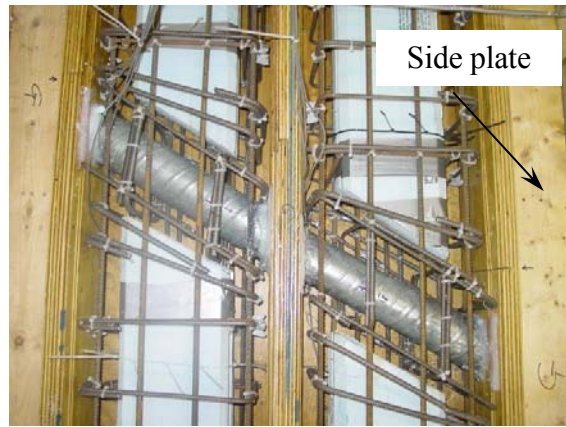
(d) Intermediate diaphragm for interior beams
