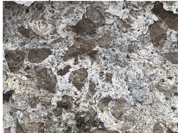
(d) Close up view of the scaled area
