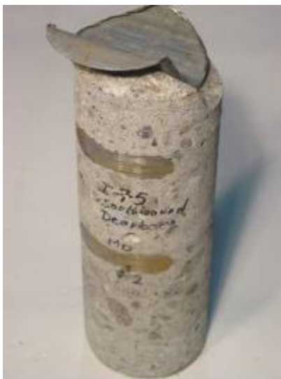
a. Rust traces
