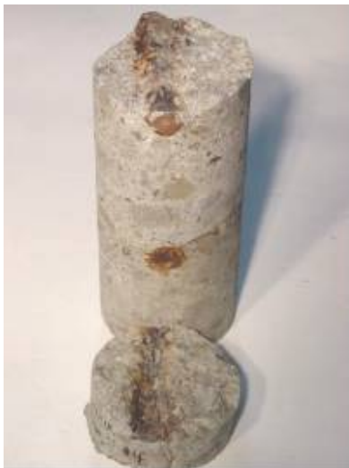
a. Rust traces
