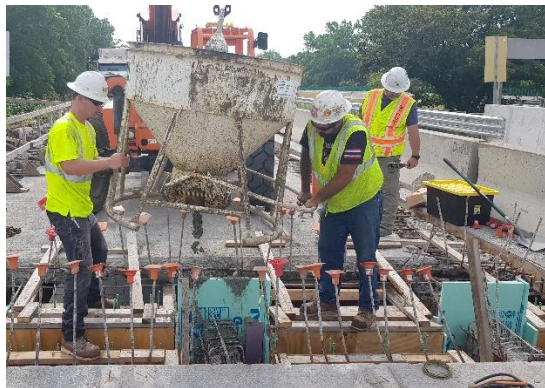
(a) Pouring concrete
