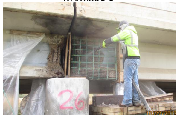
(d) Exterior face of the fascia beam
