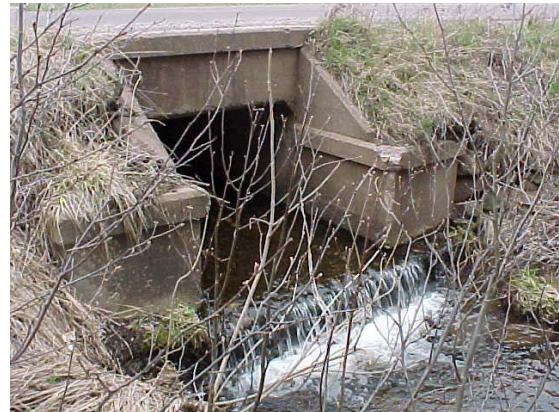
Box culvert (has poured bottom)
